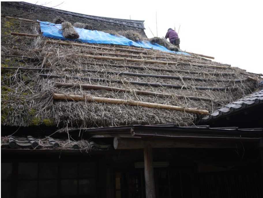
2011年1月 北側を一部修復
